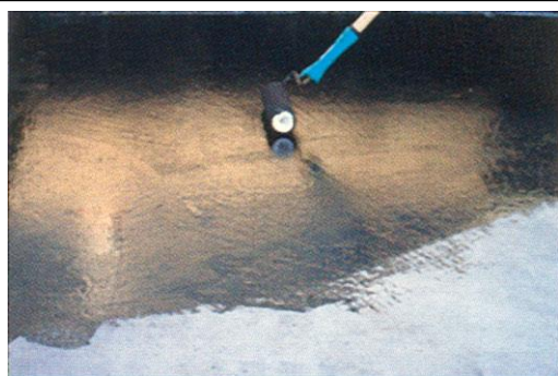
Rys. Nakładanie podkładu gruntującego
