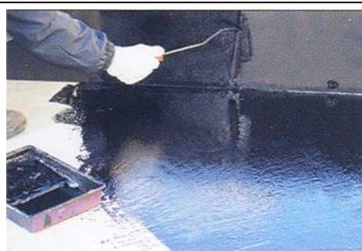
Rys. Nakładanie podkładu gruntującego
