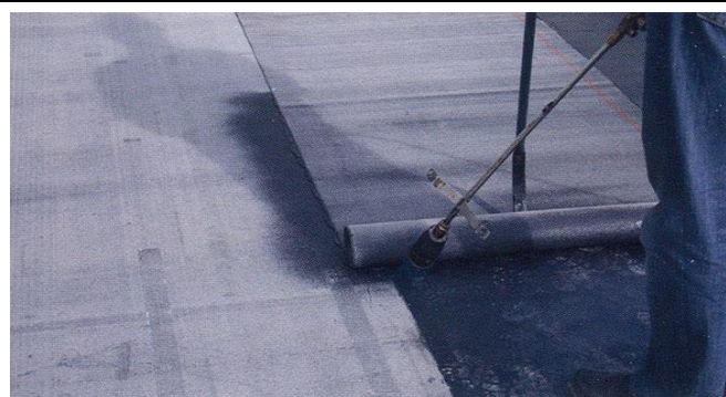
Rys. Przygrzewanie warstwy paroizolacyjnej
